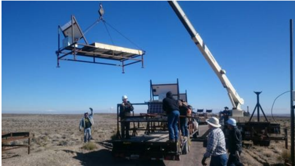
図 6.2: ステージングエリアにクレーンで配置される SD の外観
