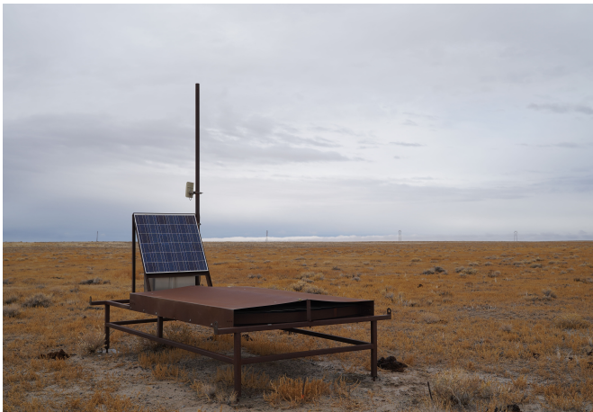
(a) TA サイトに設置されている SD の写真
