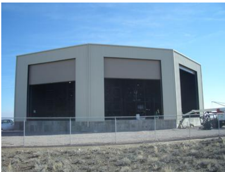
図 3.2: 現地で建設された望遠鏡ステーション (Black Rock Mesa)。観測をしないときはシャッターが閉まるようになっている。
