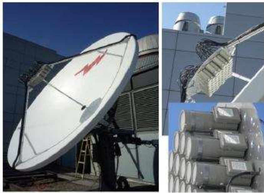
図 2.4: 左: 53 ch の feeds を備えた MIDAS のアンテナ。右: feed 部分の拡大図。
