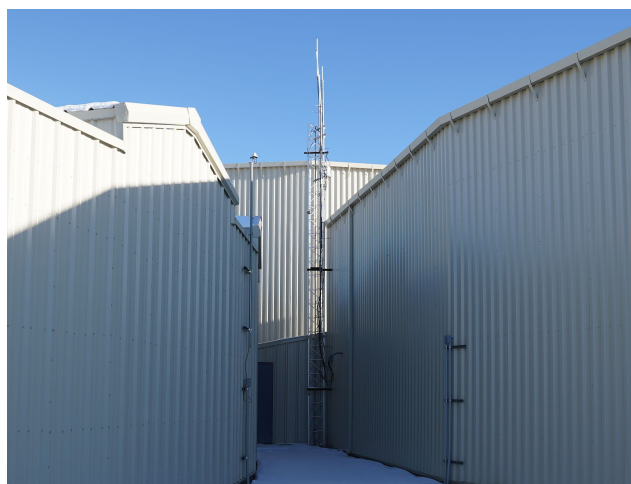
図 2.7: TALE-infill SD アレイ用のデータ通信塔。中央に写る鉄塔の頂点に取り付けてあるのが無指向性アンテナ、中腹にある白い箱がアクセスポイントである。右手前の建物が TA MD、奥の少し背が高い建物が TALE FD である。
