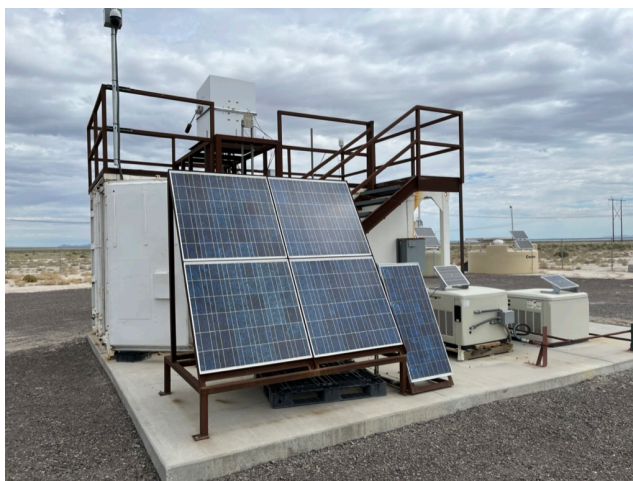
図 5.3: CLF の電力供給システム
