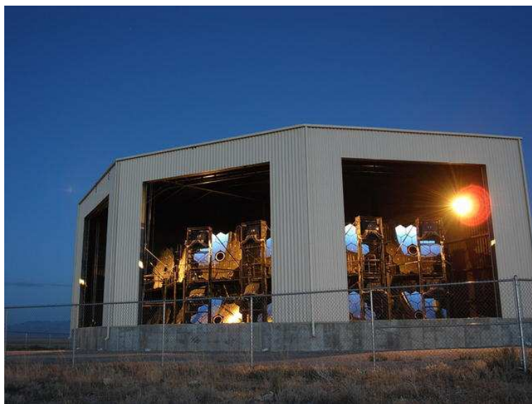
図 2.3: FD ステーション (Black Rock Mesa サイト) の外観
