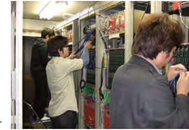
Installation work of new front-end electronics データ収集システムの入替え作業
