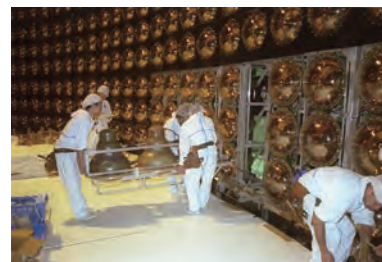
Installation of inner detector PMTs 内水槽の光電子増倍管取り付けの様子
