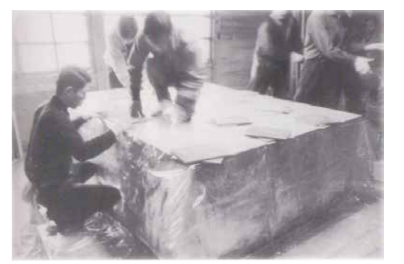
空気シャワー観測のための大型エマルジョンチェンバーを組み立てる (1966 年ごろ)
