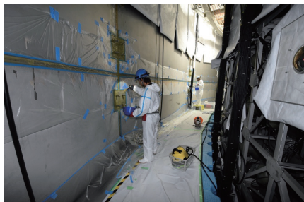
図3. 2018年に行われた止水補強工事の様子
