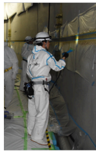
図 1 : (左) 水漏れ止水作業。タンク外壁の溶接部分を止水材で塞ぐ。(右上) 故障した光電子増倍管の取替作業。(右下) 配管作業。
