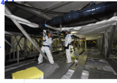
図 1 : (左) 水漏れ止水作業。タンク外壁の溶接部分を止水材で塞ぐ。(右上) 故障した光電子増倍管の取替作業。(右下) 配管作業。
