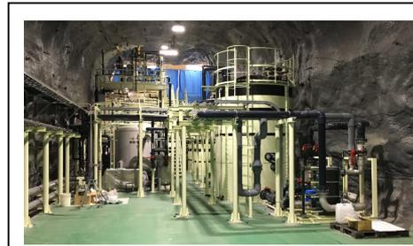
図 2 : 神岡地下施設内で建設中の SK-Gd 実験のガドリニウム水純化装置
