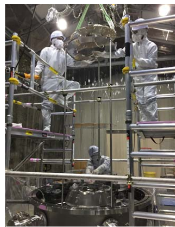
図 2. Type-A 防振装置のインストール作業。
