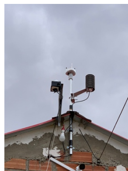
Figure 1 気温、湿度、雨量、風量測定用の環境モニター
