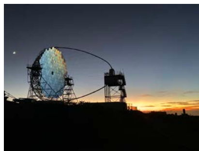
図 1.LST1 号機。口径 23m 主鏡の焦点面に PMT1855 本からなる書店面検出器が置かれている。
