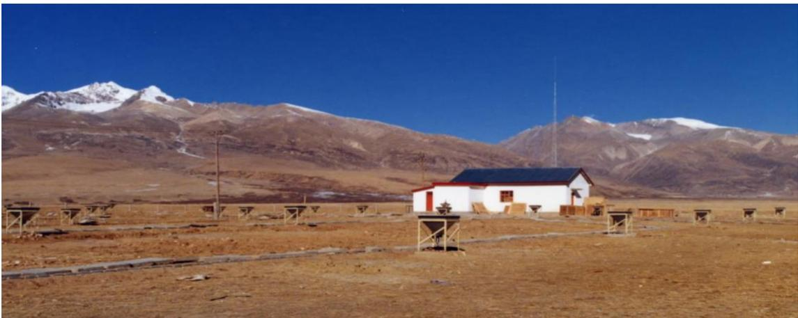
図Ⅲ-5.3. 設置完了直後のTibetI空気シャワー観測装置と実験室建屋。1990年1月撮影。
