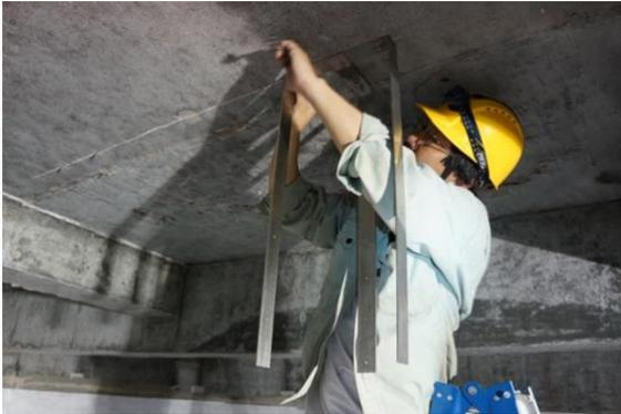
光電子増倍管支持具の取り付け
