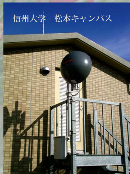
↑黒い半球がアンテナで、白いボックスに本体（SINELINK5G 高速無線レピータ装置）が収納されています。
