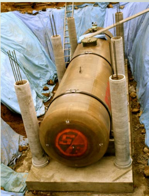
新しく設置された重油地下タンク
