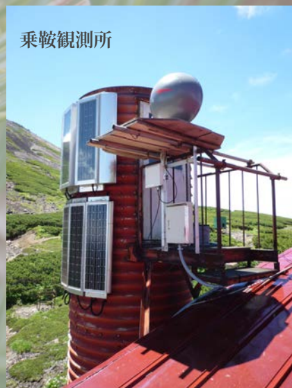
↑黒い半球がアンテナで、白いボックスに本体（SINELINK5G 高速無線レピータ装置）が収納されています。
