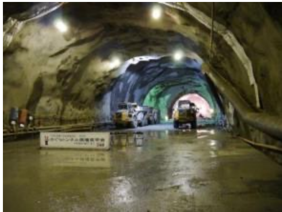
掘削直後のトンネル
