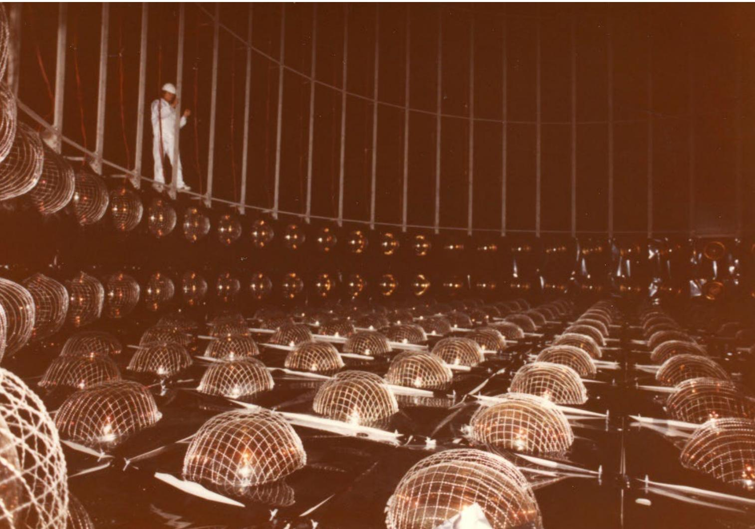
底面と側面2列の光電子増倍管を取り付け終えた時の写真。
