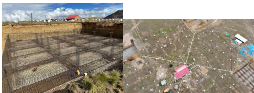
図 4 鉄筋配筋がすすむ地下ミュー粒子検出器 (左) 3 箇所の掘削状況 (R8 年度 4 月に 4 箇所の掘削を完了した) (右)
