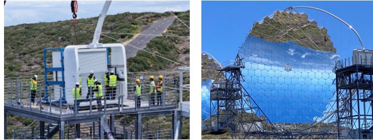
図2：2025年5月に行われた、焦点面カメラのLST 4号基への取付作業(左)と取付後のLST 4号基(右)。
