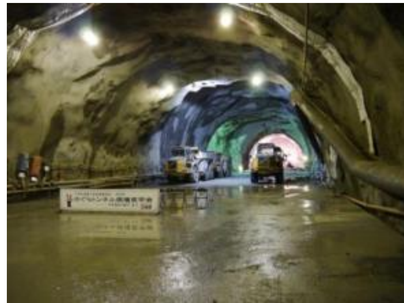
掘削直後のトンネル
