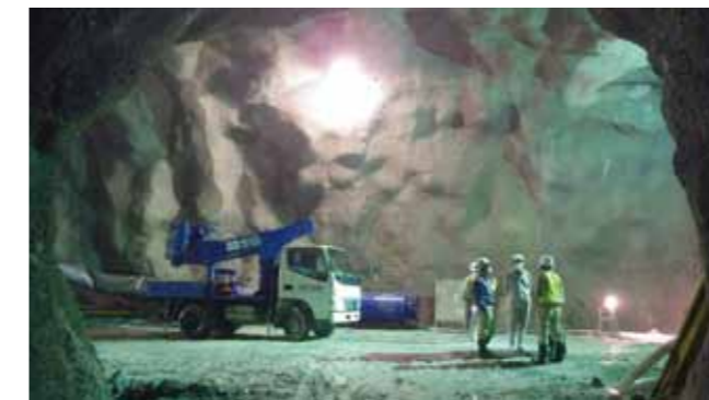
図3 掘削中のKAGRA用のトンネル。 Fig.3. Tunnel for KAGRA under construction.
