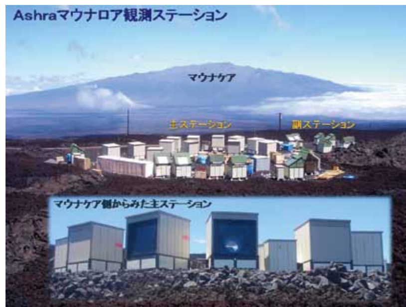
図1 建設を終えたAshraマウナロア観測ステーションの全貌です。全天の80%の視野を昆虫の複眼のように一望する主ステーションと、同様に天頂付近を見る副ステーションがあります。これによって、全天30%は「両眼」で見られるわけです。下は、マウナケア側から見た水平方向を眺む望遠鏡群です。山から出現するニュートリノの姿が見られるかもしれません。天体から来る超高エネルギーニュートリノが宇宙の謎を解く鍵となります。
