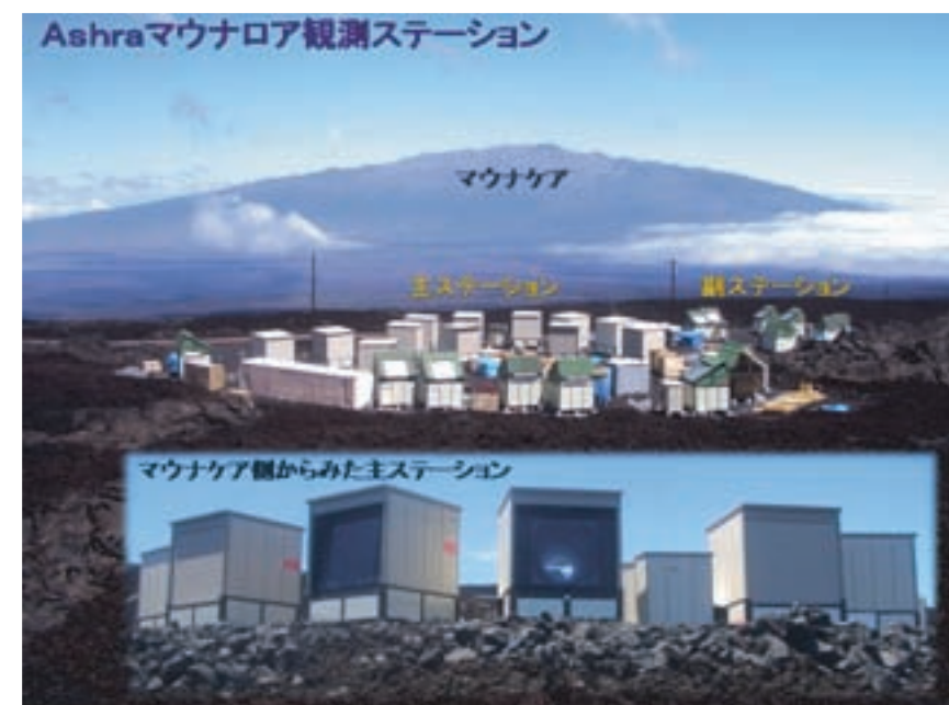
図1 建設を終えたAshraマウナロア観測ステーションの全貌です。全天の80%の視野を昆虫の複眼のように一望する主ステーションと、同様に天頂付近を見る副ステーションがあります。これによって、全天30%は「両眼」で見られるわけです。下は、マウナケア側から見た水平方向を眺む望遠鏡群です。山から出現するニュートリノの姿が見られるかもしれません。
