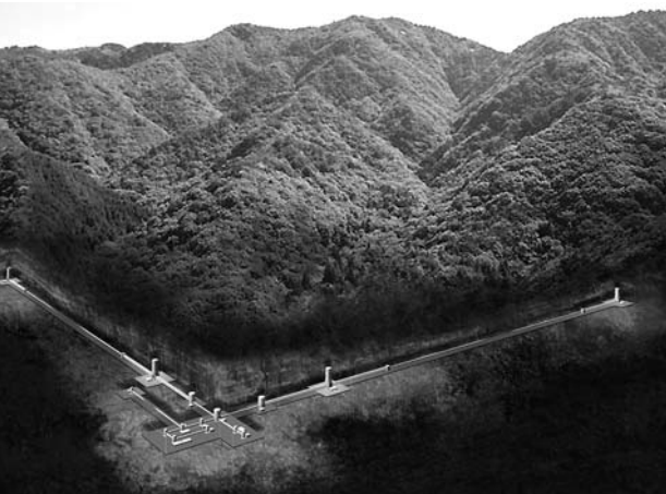
計画中の重力波検出器のイメージ 大型のものでは世界で初めて。 振動の少ない地下に設置する計画
