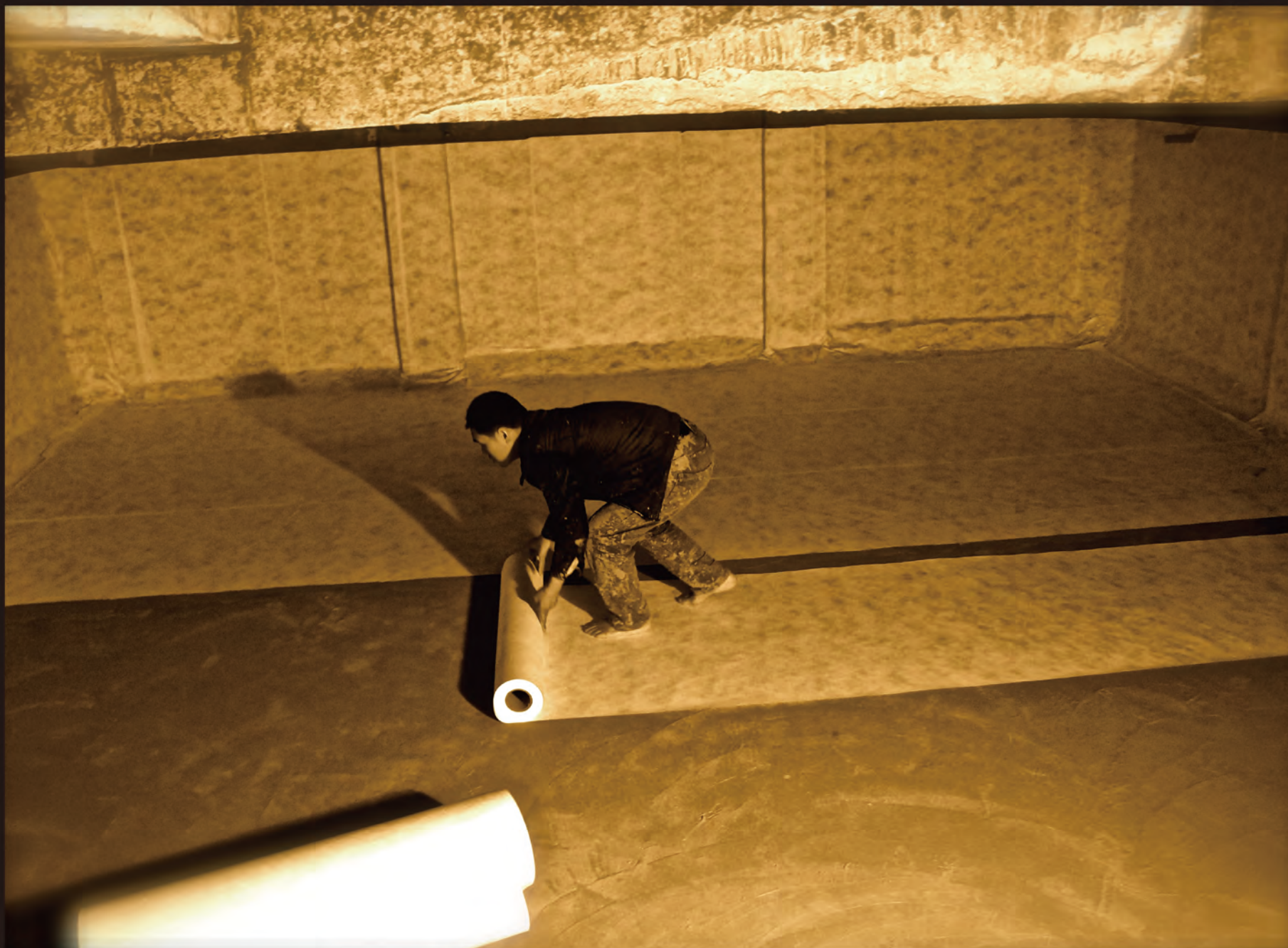
■ チベット地下ミュオン検出器内部でのタイバック反射シート取り付け作業風景。
