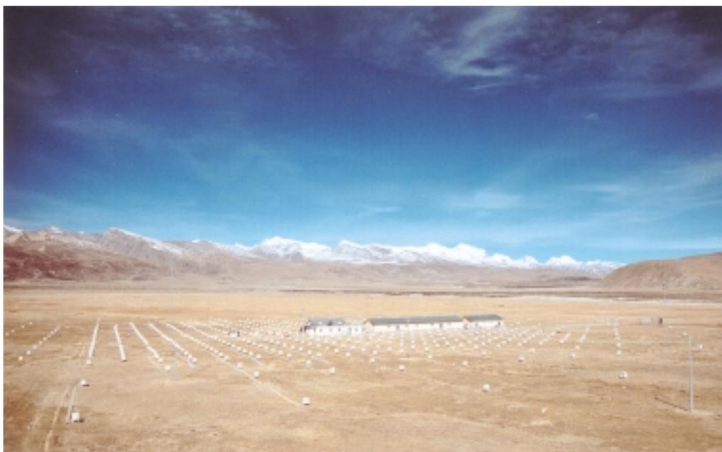
写真10：99年11月に完成した高密空気シャワーアレイ。545台の検出器からなり、680Hzの頻度でデータを収集している。
