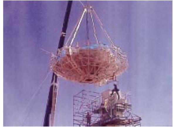
図3：クレーンでつり上げられた主鏡が回転駆動部に取り付けられるところ
