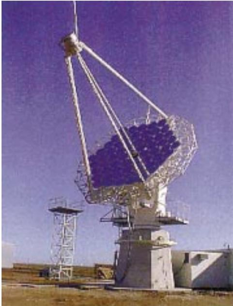
図1：完成したCANGAROO 新7mチェレンコフ望遠鏡
