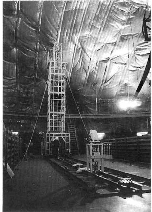
図3 ビームパイプ挿入用やぐら (手前は、設置前の90°偏向磁石)
