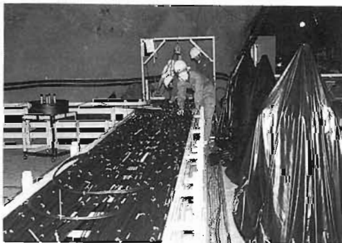
写真5：光電子増倍管の取付から数日遅れてケーブルをエレクトロニクスハットまで引きのばす作業が始まります。光電子増倍管の位置により、余るケーブルの長さが違い、その長さの違いは写真にあるように水槽上面に設置されたケーブルトレイ上で調整します。長いものでは50メートル以上もこの上でのばさねばならず、予想をはるかに超えて体力のいる作業です。
