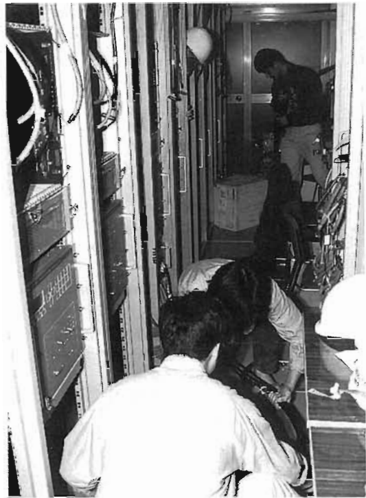
写真6：引き延ばされたケーブルはエレクトロニクスハット内でエレクトロニクス、高電圧電源に1本ずつ接続します。エレクトロニクスでいっぱいになった部屋で細かい作業が多く大変です。写真のエレクトロニクスハットと同じものが水槽上面に4個あります。(8月撮影) (神岡実験推進部)
