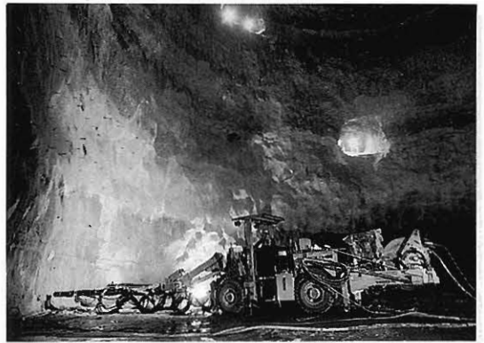
写真6 ロックボルトの孔を穿孔する油圧ジャンボ。平成6年3月撮影。
