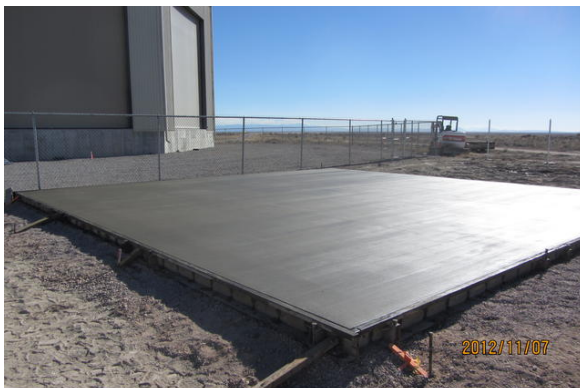
アンテナ設置用コンクリートパット
