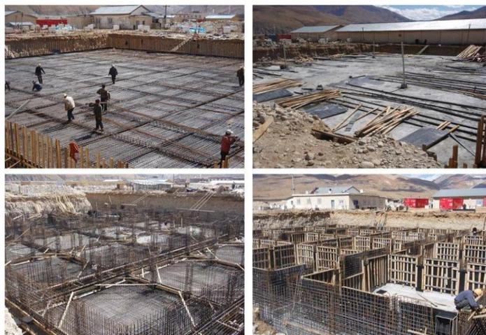
図2 断面積約 830  $m^2$ の水チェレンコフ検出器用水槽のクラスター4個(4個の総面積 3300 $m^2$ )の建設状況。水槽の水深は 1.5mで、これにコンクリートの蓋をしてその上に 2mの土を盛り堅める。水槽は平成 22 年度に竣工した。
