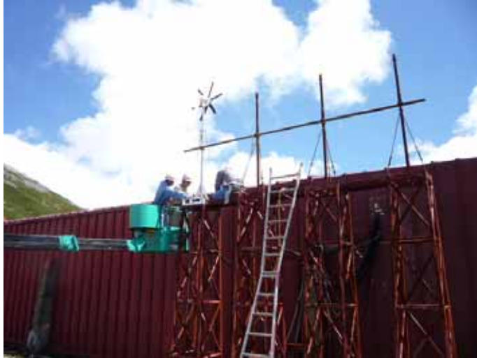
9月5日設置工事
