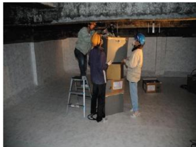
天井への取り付け
