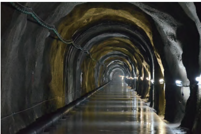
図2：KAGRAで新たに掘削され、コンクリート吹き付け塗装、および、床コンクリート舗装がなされた、長さ約3kmのトンネル。写真はYアーム(東茂住側に伸びるトンネル)。
