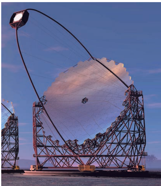
図3：CTA大口径望遠鏡想像図。口径23m、重量103トンであり、主鏡の総面積は396m 2 であり、20GeVから1TeVを主要なエネルギー領域としての観測を行う。観測できる宇宙を赤方偏移 z=4 まで拡げる。ガンマ線バーストの追観測のため、20秒でポインティングできる駆動性能を持つ。
