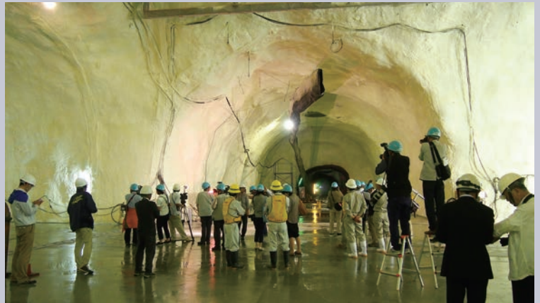
KAGRA トンネル報道機関向け見学会の様子
