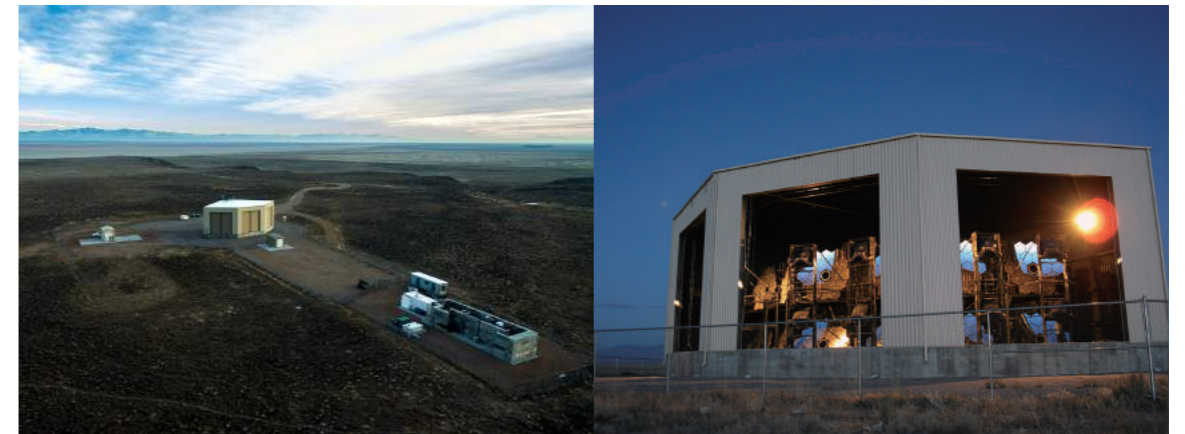
(図2) 左がアメリカユタ州にあるTAサイトであり、中心にある扇形の建物がTA大気蛍光望遠鏡ステーションである。右は、大気蛍光望遠鏡ステーションであり、3.3 m口径の複合球面鏡とその焦点面には256本の光電子増倍管からなるカメラが設置されており、12基で1地点の大気蛍光望遠鏡ステーションを構成する。
