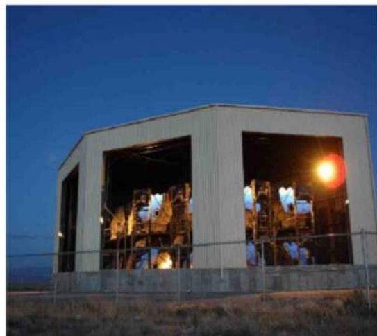
FDステーション (FD12～14台)
