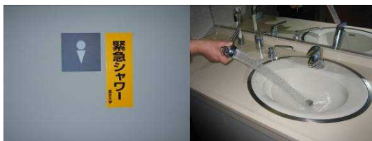
トイレに設置
