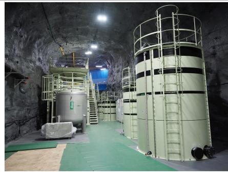
図2：神岡地下施設内で建設中のSK-Gd実験のガドリニウム水純化装置
