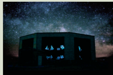
テレスコープ・アレイ (TA) は最高エネルギーの宇宙線観測を目的に米ユタ州の砂漠地帯（標高1,400メートル）に建設され、2008年観測を開始しました。地表検出器507台と大気蛍光望遠鏡3ステーションからなり、700平方キロメートルの地表面積をカバーしています。
