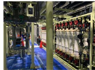
図3 : ガドリニウム水システムの一部
