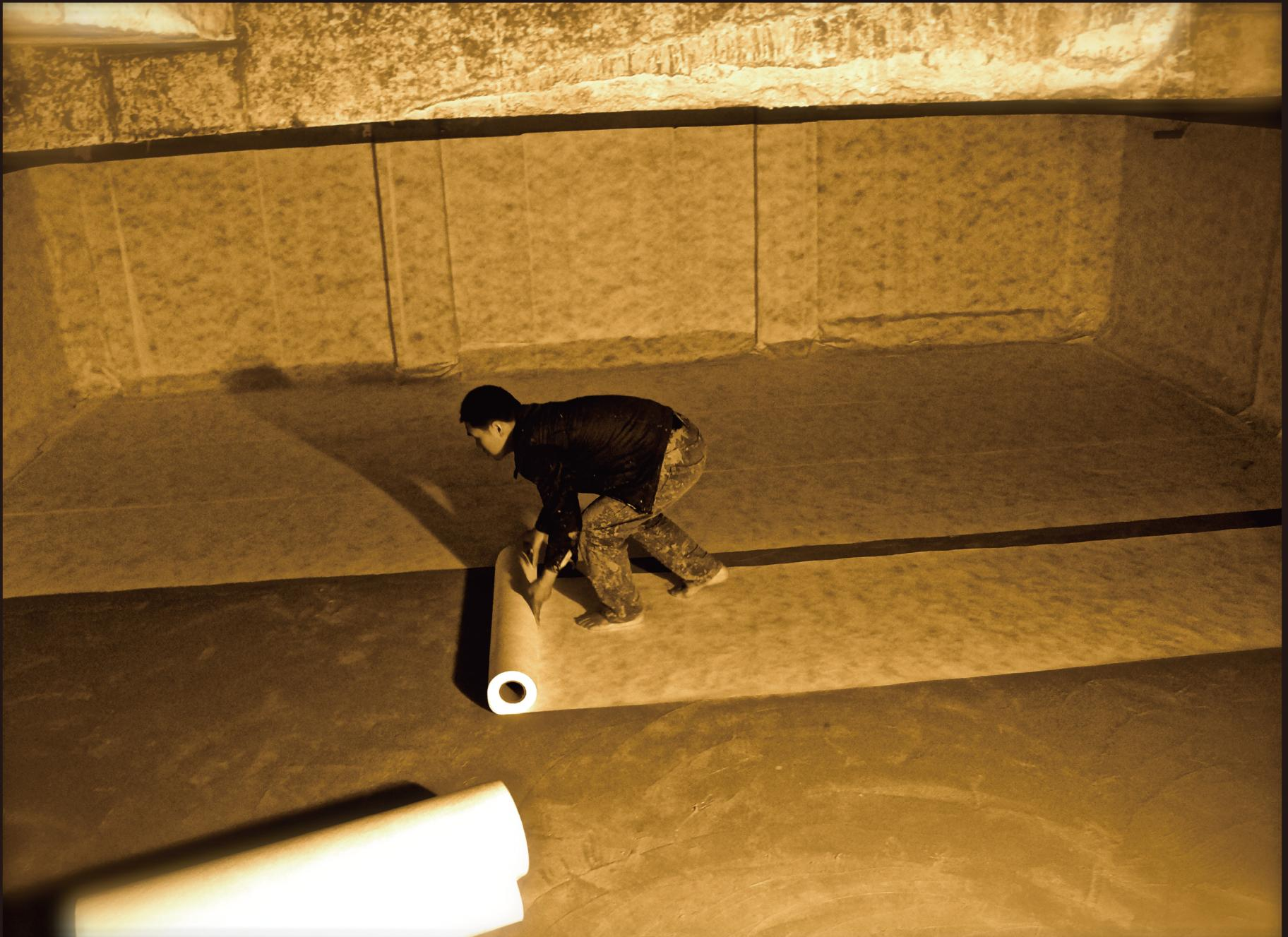
■ チベット地下ミューオン検出器内部でのタイベック反射シート取り付け作業風景。
