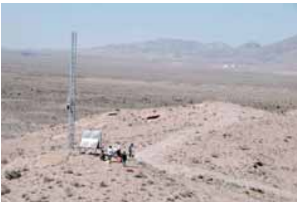
図10：TALE 実験用の無線LAN 通信塔。写真の右上には Middle Drum/TALE ステーションが小さく写っている。
