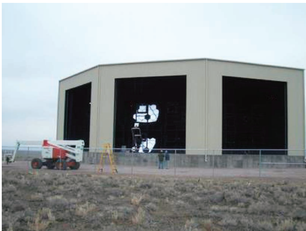
宇宙線望遠鏡 (TA) 実験の米国ユタ州現地における最初の大气蛍光観測用望遠鏡ステーション。中央の望遠鏡の上下2つの合成反射鏡が光って見えている。
