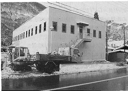
完成間近の研究棟
