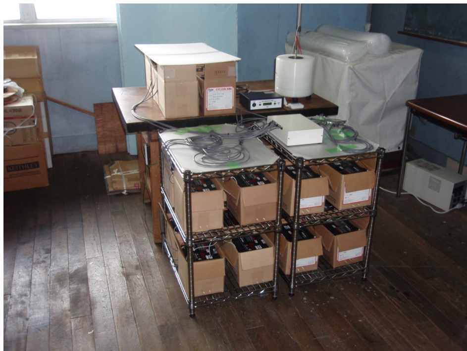
42Ah シールド型鉛バッテリー 20個
