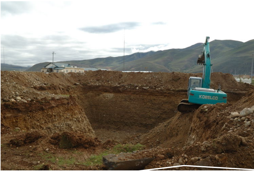
9月4日 掘削状態
