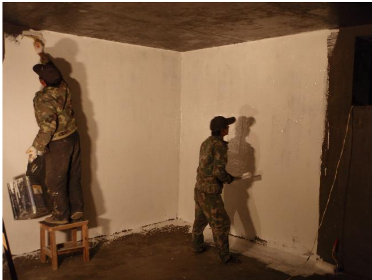
11月6日 南プール、エポキシ樹脂塗装
