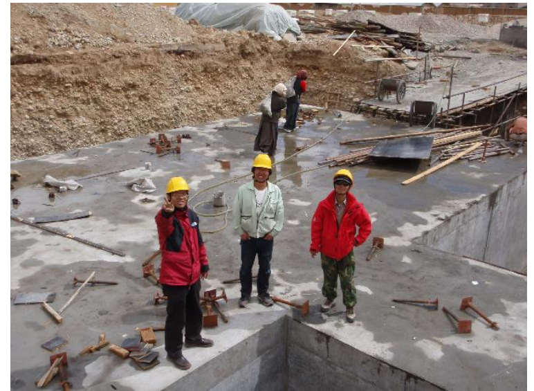
10月20日 型枠撤去
